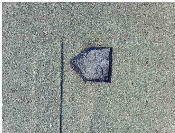
04- Fermeture et remise en état sondages réalisés
