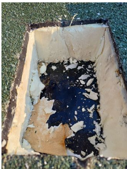
03- Détail du complexe d'étanchéité
