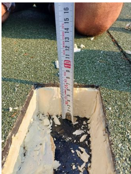
03- Détail du complexe d'étanchéité
