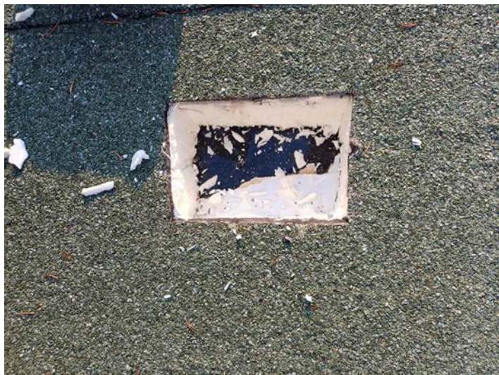
02- Réalisation de sondage
