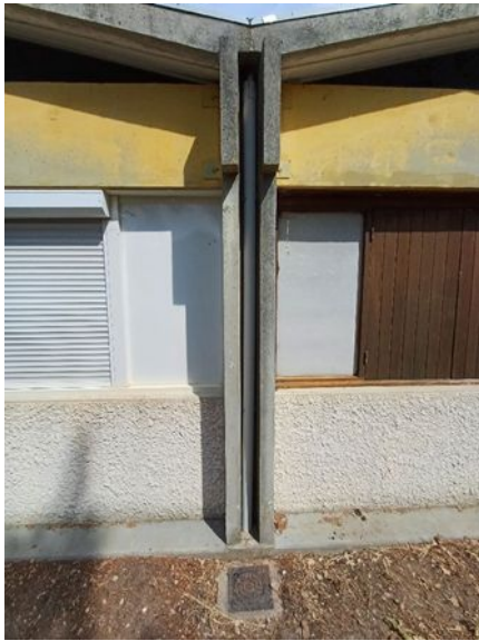
09- Contrôle visuelle des descente EP
