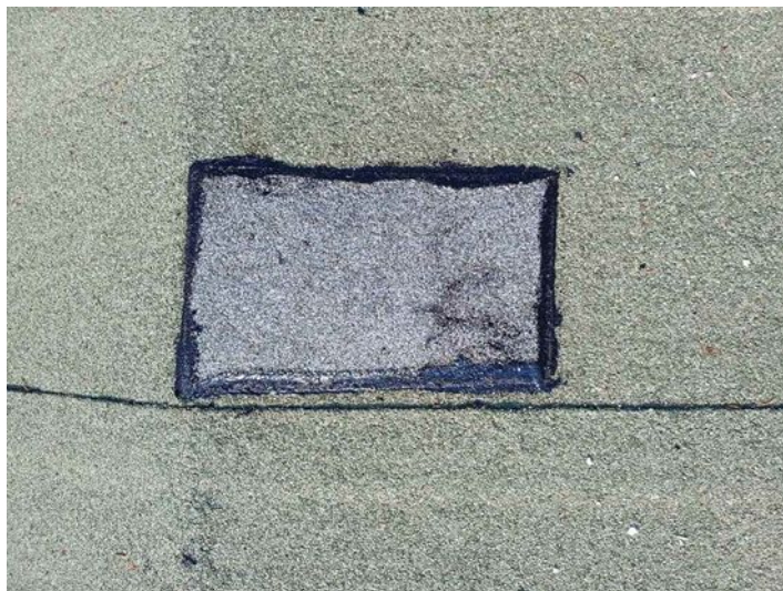
04- Fermeture et remise en état sondages réalisés
