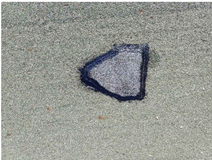
04- Fermeture et remise en état sondages réalisés
